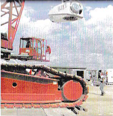
La nacelle (d'un poids de 57 tonnes) est placée au sommet du mât. L'électricité qui y sera produite est conduite par câble électrique (à l'intérieur du mât) vers le transformateur pour obtenir une tension de 20 000 volts
