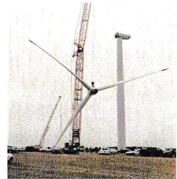
Les 3 pales assemblées sont placées sur la face avant de la nacelle. Toutes ces opérations étant réalisées avec tact et précision par la grue géante de la société hollandaise " Mammoet "
